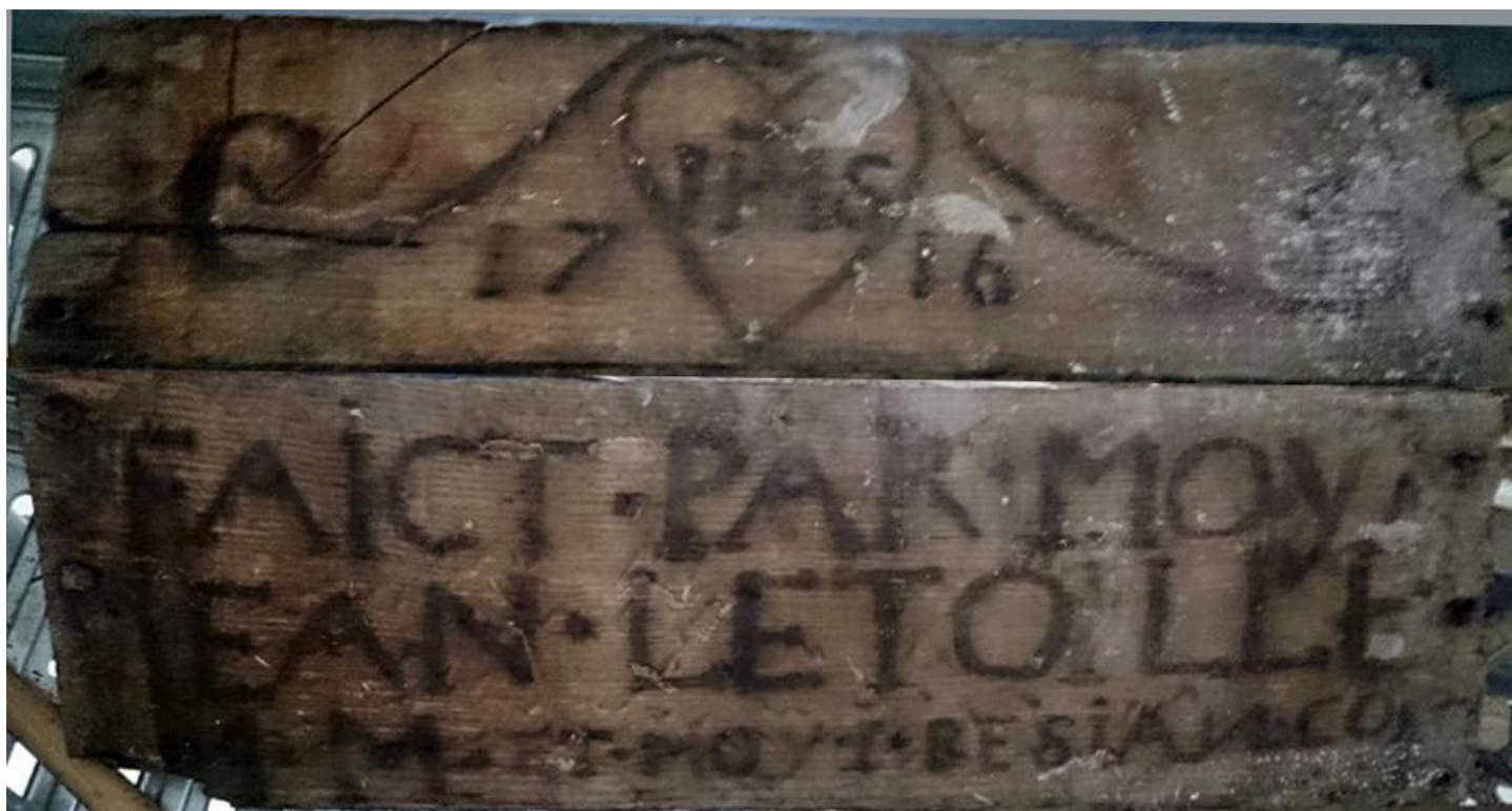
Lattes du lambris de la voûte
