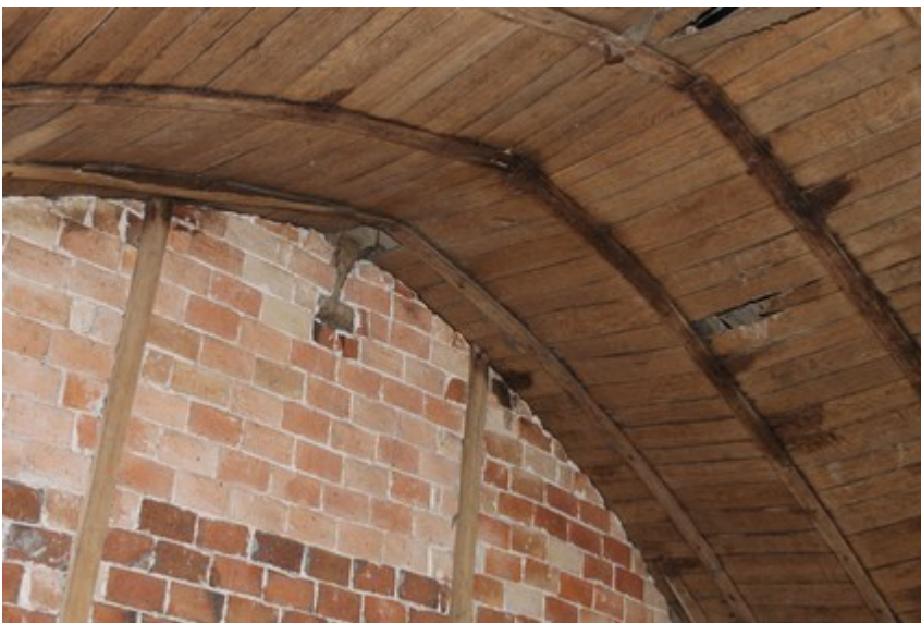
Voûte lambrissée et mur de clôture conservée entre la nef et la croisée du transept.
