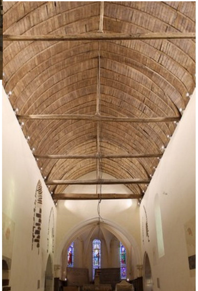
Vue vers le chœur de la nef et de la voûte lambrissée restaurées.
