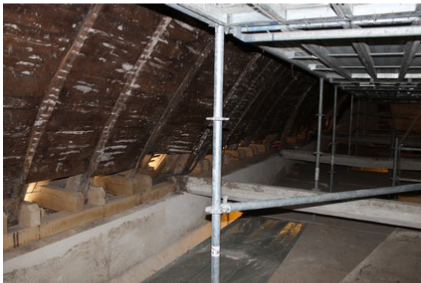
Reprise du pied de la charpente, avant nettoyage de la voûte.
