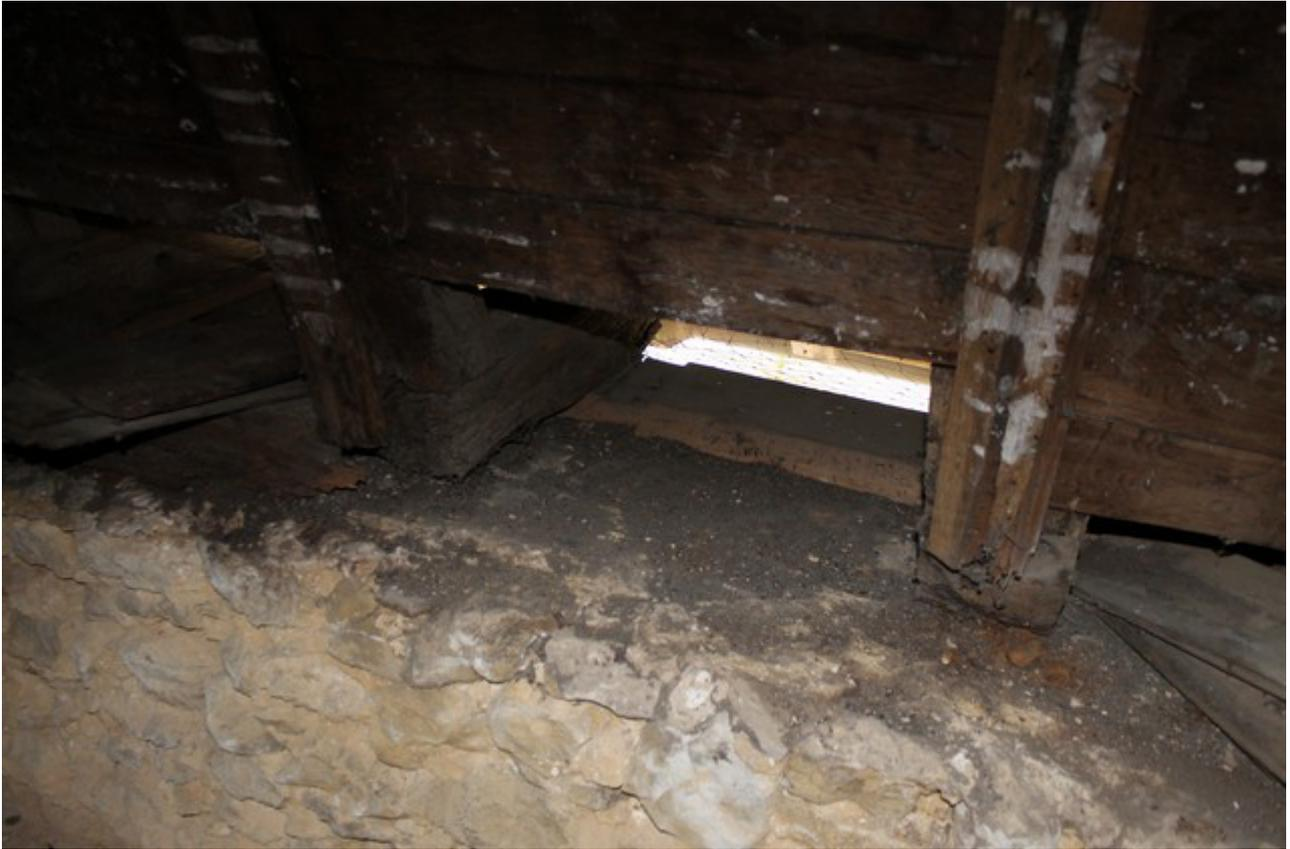
État des pieds de la charpente : les pièces de bois horizontales, posées sur l'assise du mur et devant recevoir les fermes, sont totalement pourries, voire absentes.
